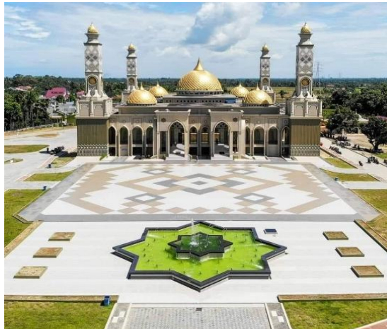
Gambar 1. Masjid Agung Baitul Ghafur Kabupaten Aceh Barat Daya
