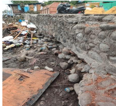
Gambar 2. Kondisi bangunan pengamanan pantai Merpati
